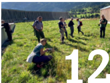
Begehung Dach Terminal
