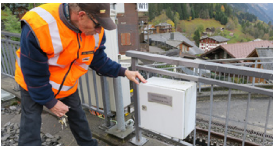
Kontrolle beim Weichenkurbelkasten
