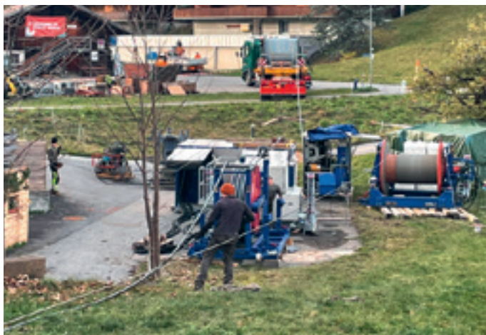
Seilzug Firstbahn – mittels altem Seil wird das neue Seil eingezogen
