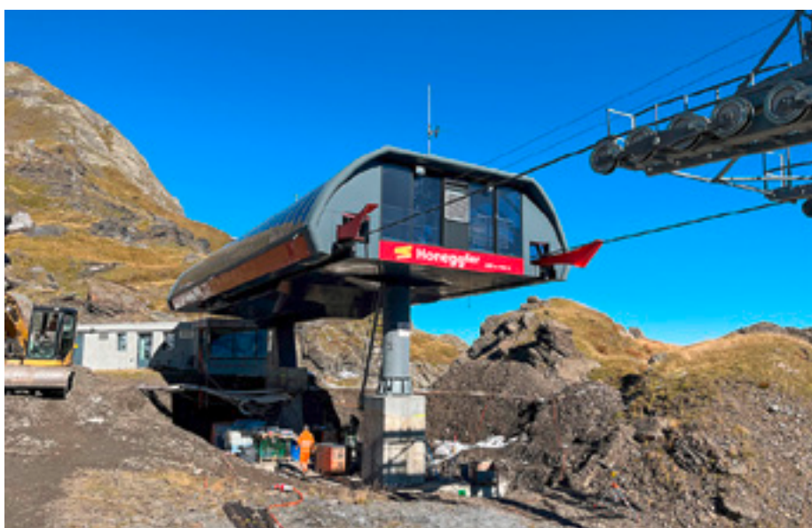
Anspruchsvolle Verschiebung der Bergstation der Honegg-Sesselbahn
