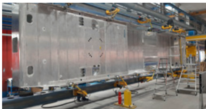
Der Wagenkasten 3 von 6 in der Aluminiumschlosserei im Aufbau – sichtbar ist der Bodenteil, bevor die Seitenwände und der Führerstand aufgebaut werden.
