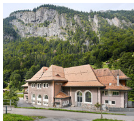
Das Laufwasserkraftwerk in Lütschental
