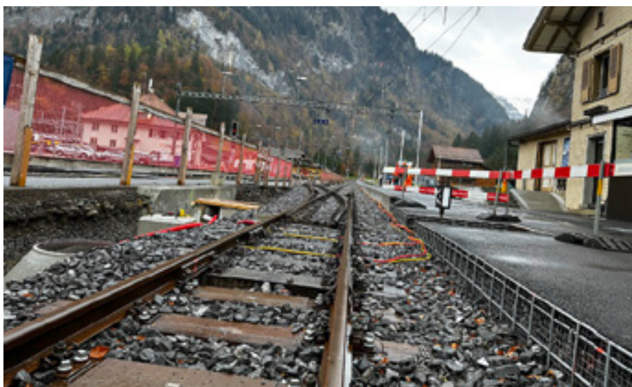
Provisorische Perronkante im Bereich der Weiche W11
