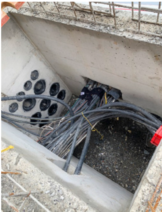
Neuer Schacht mit vorhandenen Kabel, welche in Betrieb sind und teilweise mit der neuen Sicherungsanlage ersetzt werden
