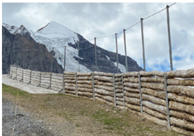
Begrünung Piste oberhalb Fallbodengalerie
