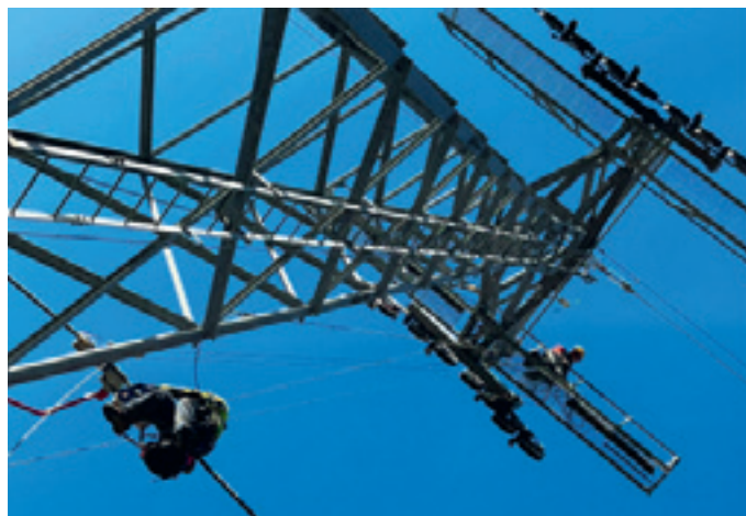
Arbeiten in luftiger Höhe bei der Firstbahn
