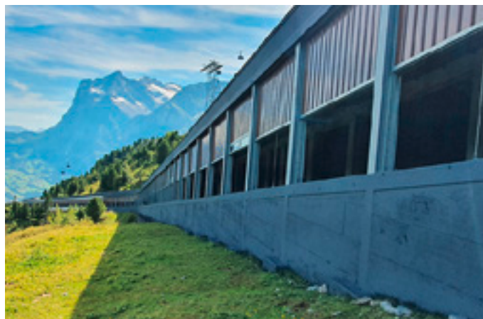
Sträatligalerie Detail Fassadenanstrich
