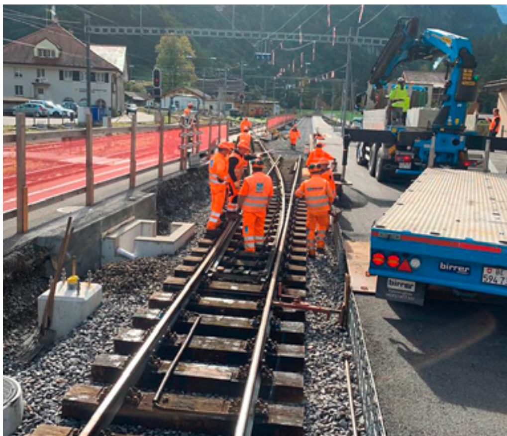
Wiedereinbau Weiche W11
