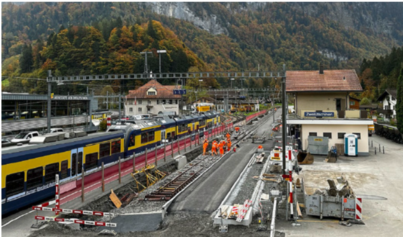
Neue Perronkante mit neuem Gleis 1
