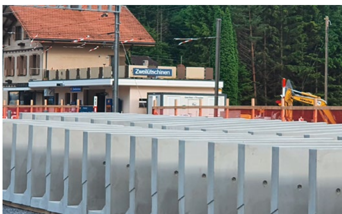
Perronwinkel warten auf Einbau
