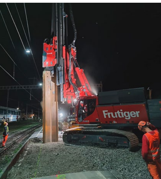
Einbau Spundwand für Baugrube
