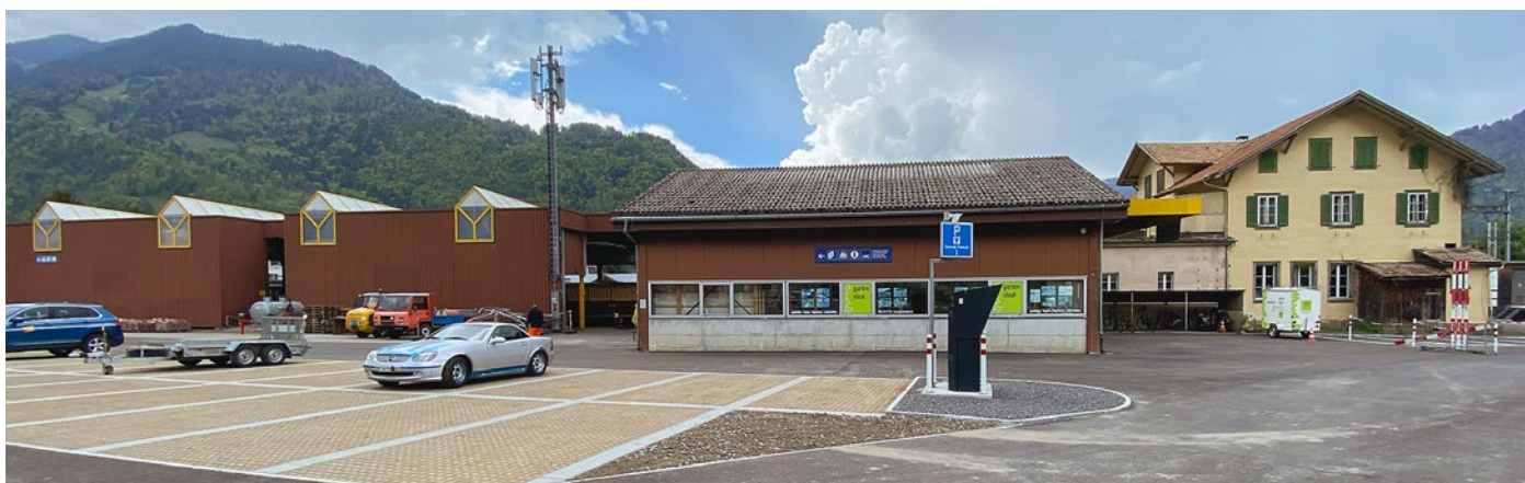
Lagerflächen entlang der Aussenfassaden
