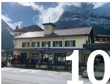
Sanierung Bahnhof Grindelwald
