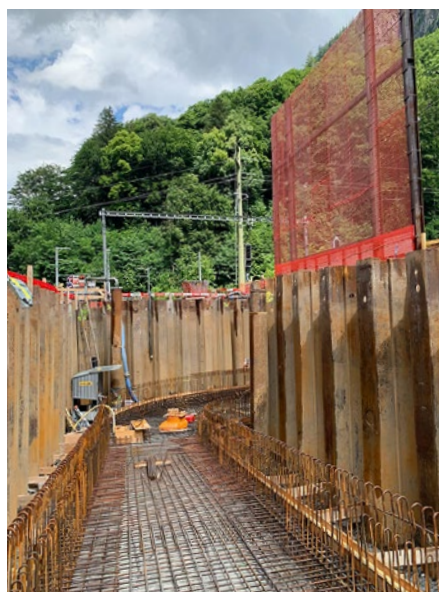
Armierung Bodenplatte Rampe und künftige Unterführung
