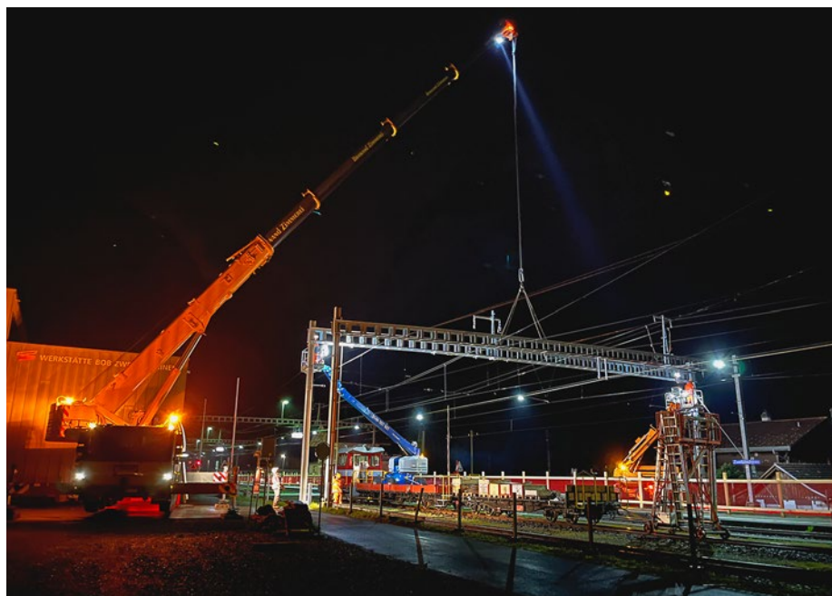
Einbau Fahrleitungsjoch
