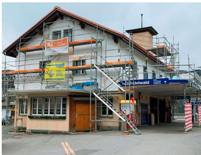
Fassade Renovation Bahnhof Grindelwald 2021
