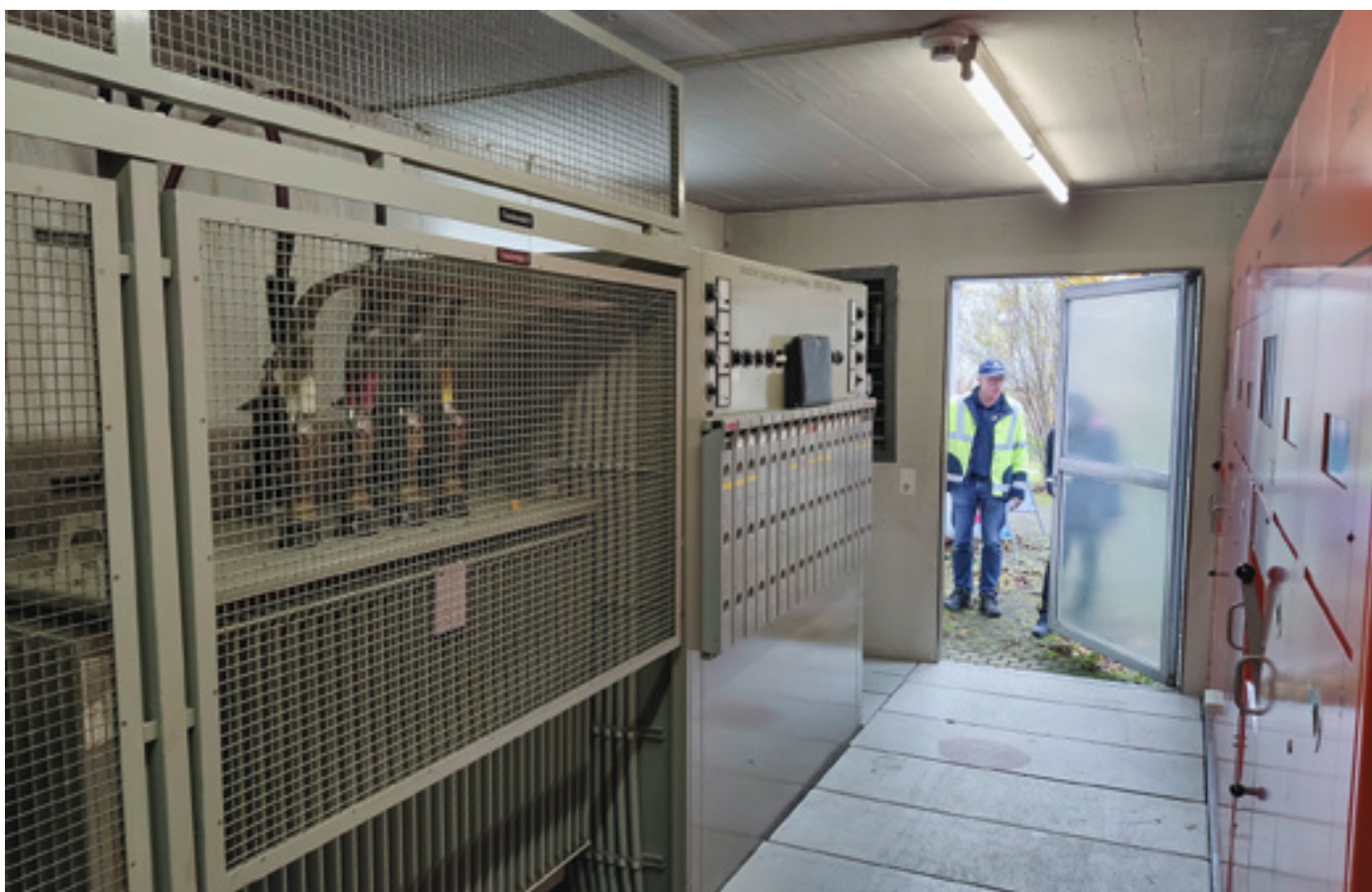
Trafostation Alpbach vor dem Umbau
