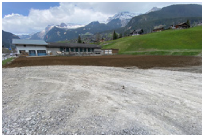
Rückbau eingekofferte Ersatzparkplätze Grund
