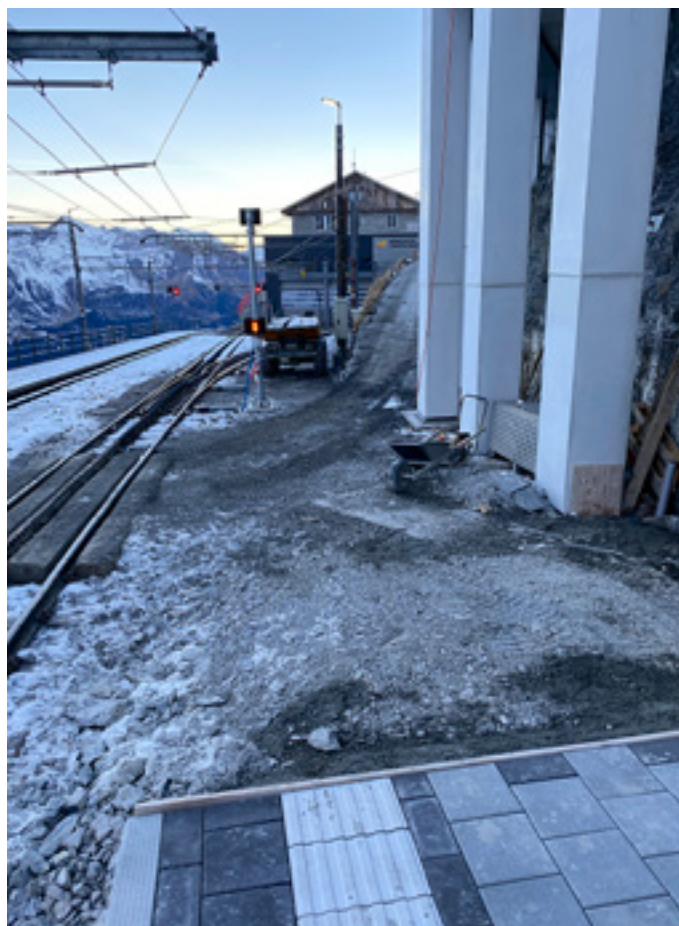
Eigergletscher: Fertigstellung Perronabschluss Gleis 2
