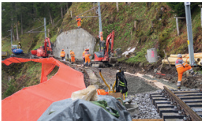
Vorarbeiten für Gleise, Kabelrohrblock und Sammelleitung
