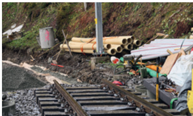
Rohrelemente für die Sammelleitung in der Wasserschutzzone
