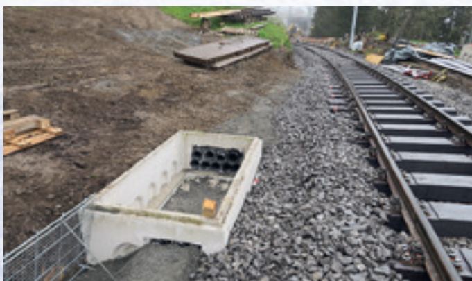
Ein neuer Kabelrohrblock
