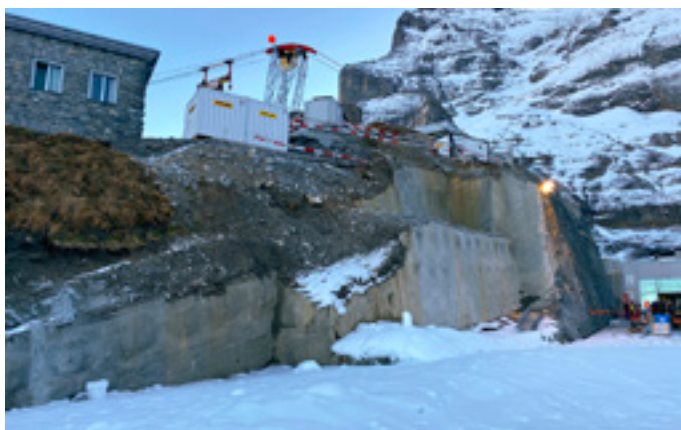
Eigergletscher: Rückbau Installation und Rekultivierung Flächen.
