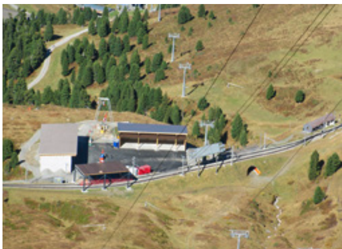
Rückbau Installation Salzegg
