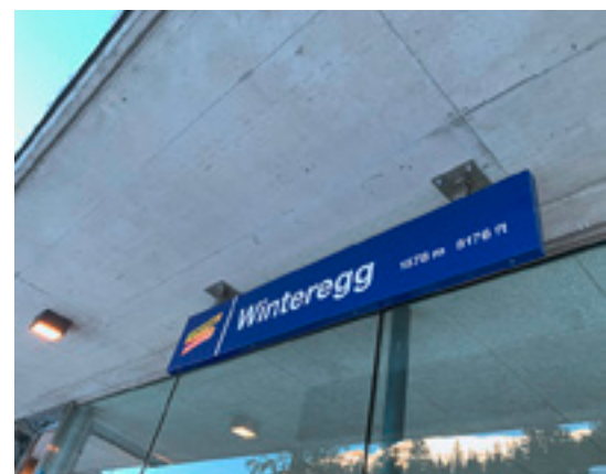
Erneuerte Station Winteregg
