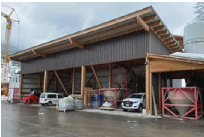
Rückbau Hallen Grund
