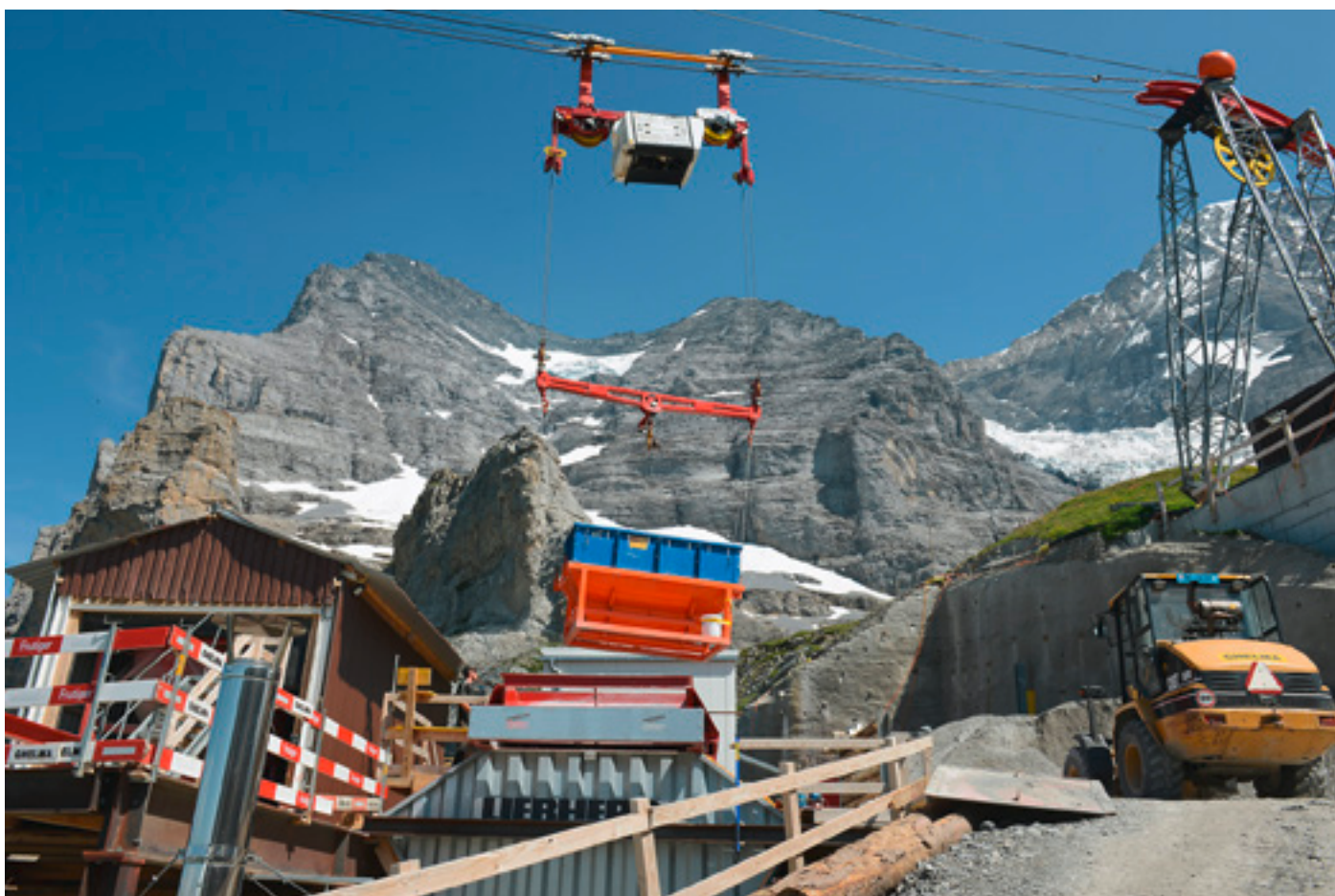
Rückbau Materialseilbahn Betonanlage
