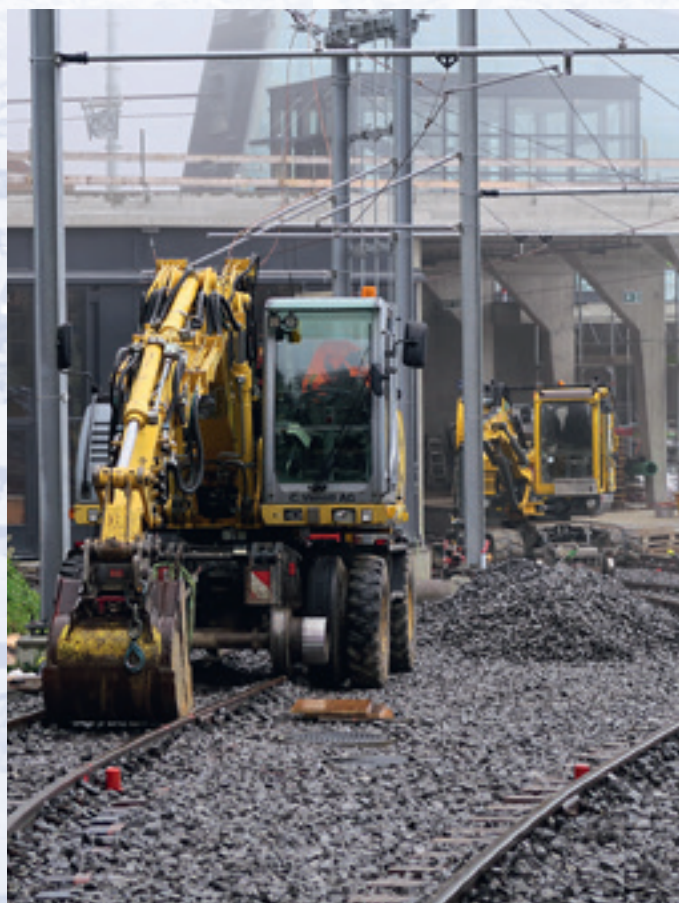
Arbeiten vor der Station Grütschalp
