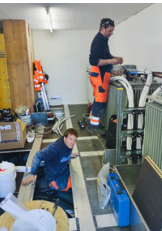
Das Netzteam des Kraftwerks während des Umbaus im Einsatz (links Martin Willener und rechts Christoph Nebiker)
