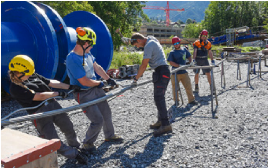
Das Seil für den Eiger Express wird zusammengespleisst
