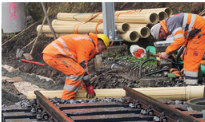
Handwerker der Frutiger AG beim Einbau der Sammelleitungsrohre
