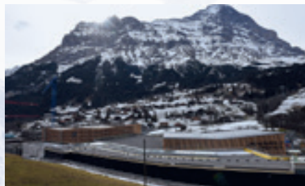
Baustelle Terminal Mai 2020
