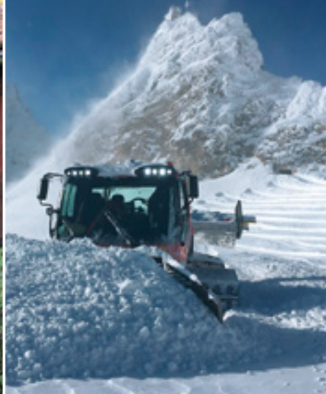
Erstellen der Schneewalme
