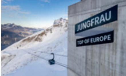
Bergstation Eiger Express
