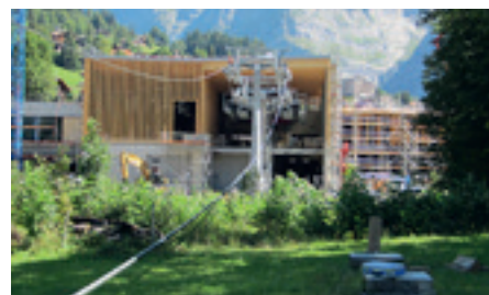
Talstation Eiger Express
