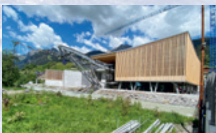
Talstation Eiger Express
