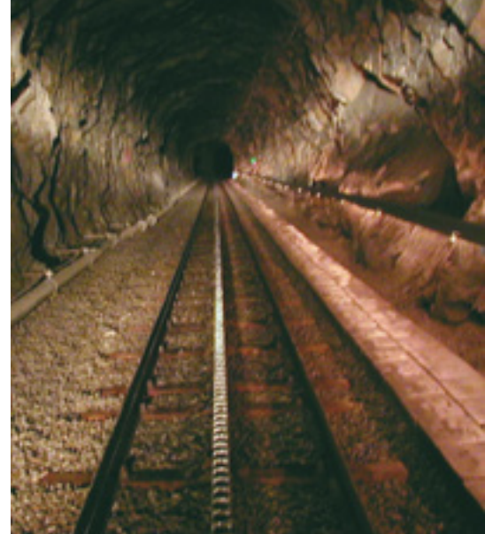
Handlauf mit Beleuchtung
