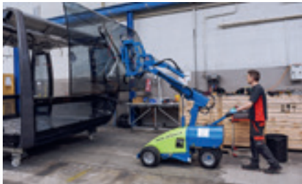
Kabinenbau CWA: Montage Scheibe
