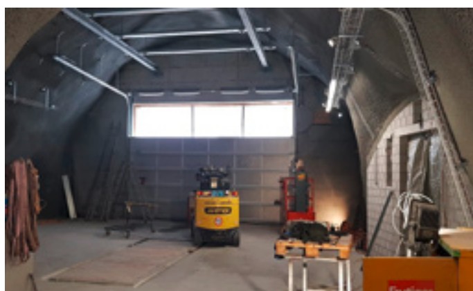
Innenansicht der neuen Pistenbully-Garage
