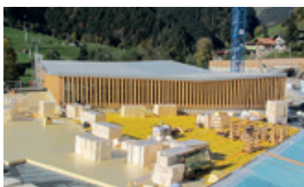
Dach Talstation Männlichenbahn
