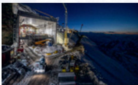
Baustelle Eigergletscher bei Nacht
