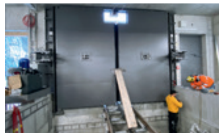
Tor zum neuen Stumpengleis 3
