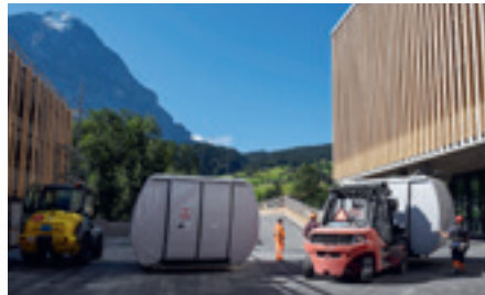
Kabinentransport Eiger Express Talstation
