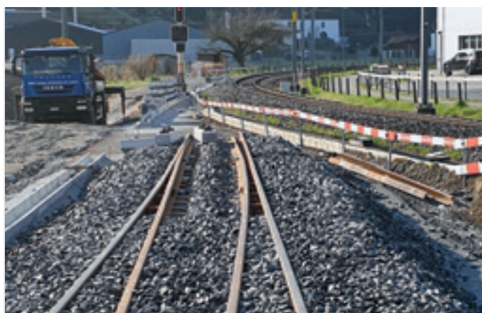
Vor der Gleisverschwenkung
