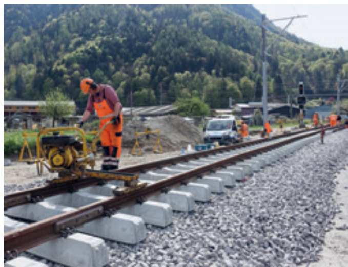
Gleisverschraubung auf Schwellen
