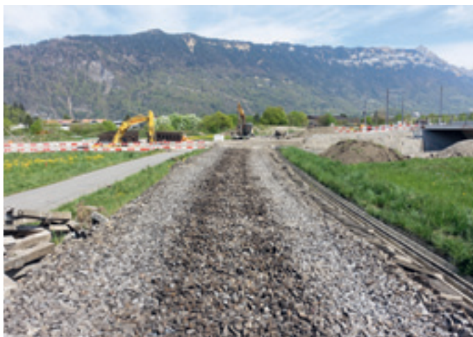
Alte Linie / Gleis und Schwellen sind rückgebaut
