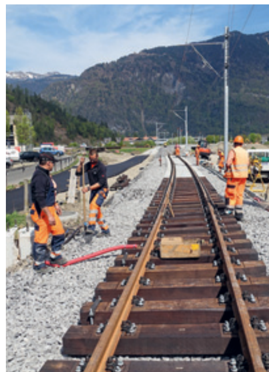
Übergangsbereich Holz- auf Betonschwellen: Gleisbau bereit für Vorschotterung/Anpassung Sicherungsanlage/ Erdung
