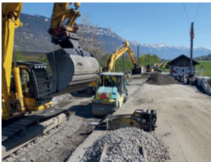
Unterbau mit Vorbereitung Sperrschicht
