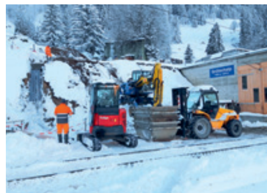
Bau Rohrblock Station Grütschalp
