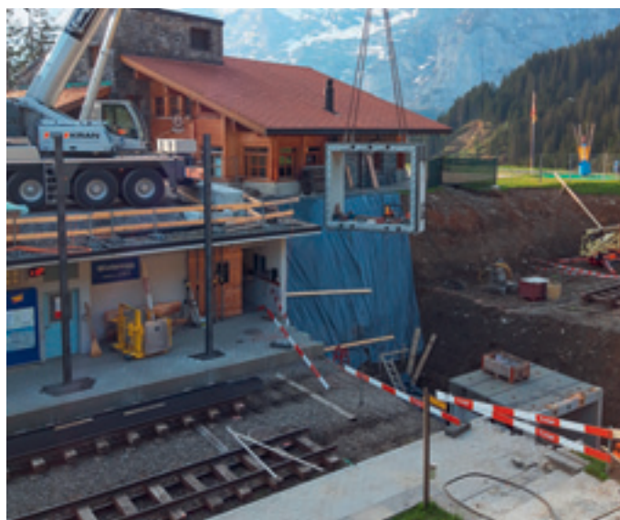
Bild rechts: Kran Unterführung
