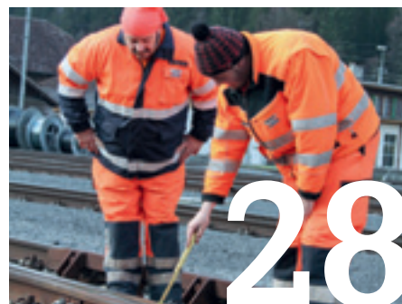
Abwechslungsreiche Arbeit als Gleisbauer
