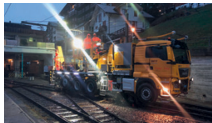
Arbeiten Fahrleitung in Mürren
