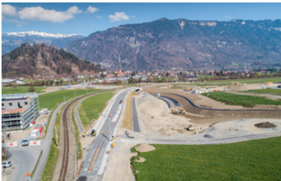
Flugaufnahme – altes und neues Trasse mit Direktanschluss
