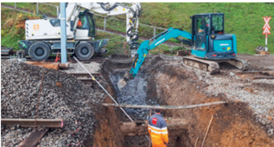
Gleisquerung mit Rohrblock Station Grütschalp
