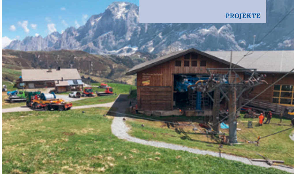
Arbeiten für Seilersatz bei der Firstbahn, Höhe Schreckfeld
