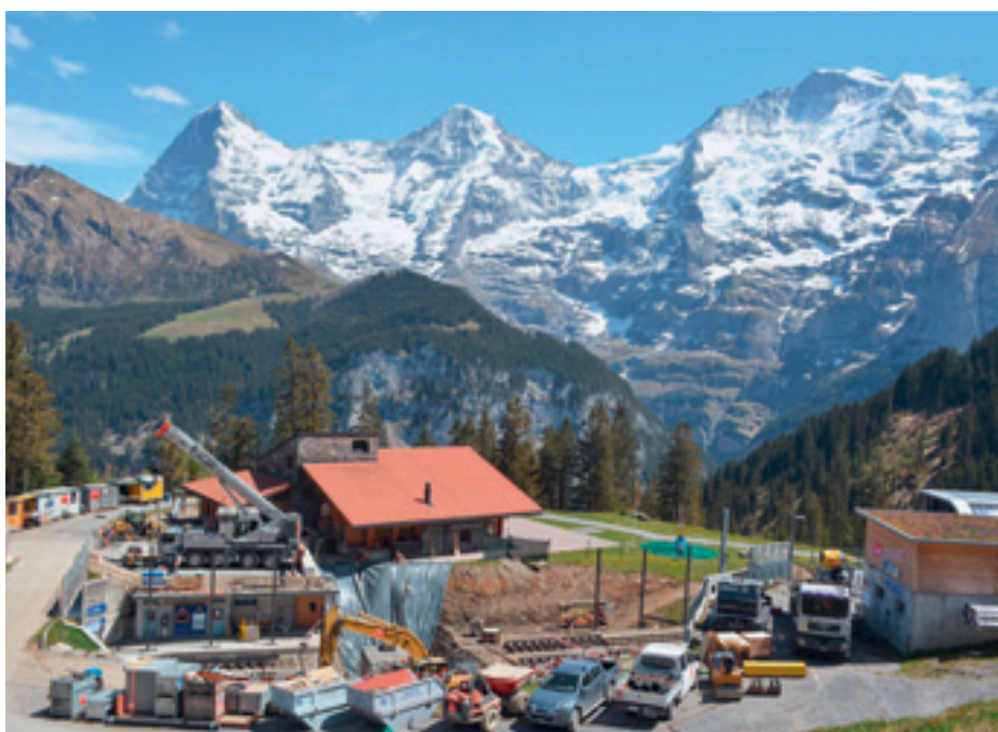
Trotz Baustelle lockt die Sicht auf Eiger, Mönch und Jungfrau
