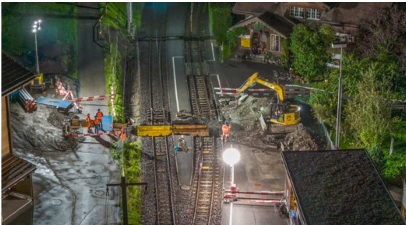
Im Herbst 2025 wurde bei der Haltestelle Lüttschental eine Gleichrichteranlage gebaut
