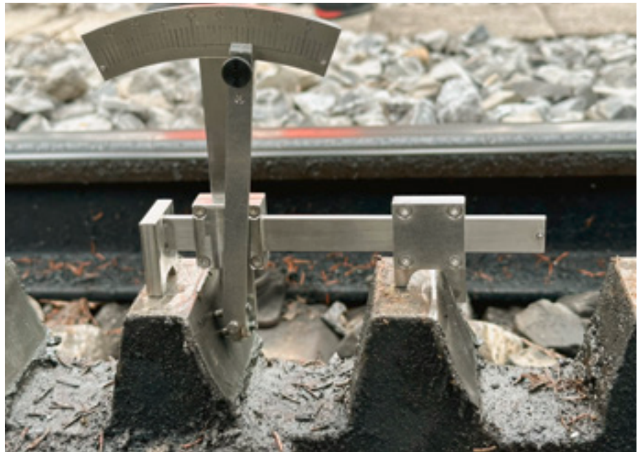
Verschleissmessung an Zahnstange (Quelle: Wengernalpbahn)
