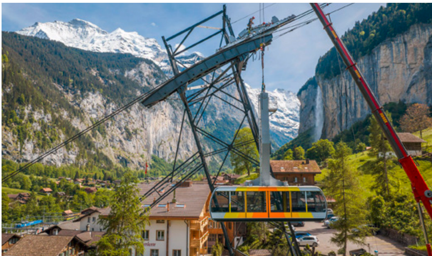
Die neue Kabine wurde mit einem Kran zum neuen Fahrwerk gehoben und montiert. Abmessungen: Länge 9,5 m / Breite 3,6 m / Höhe 2,9 m
