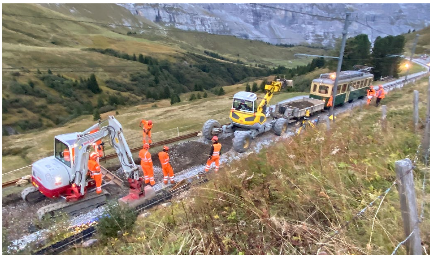
Der alte Schotter wird ausgehoben und mit dem Güterzug abtransportiert
