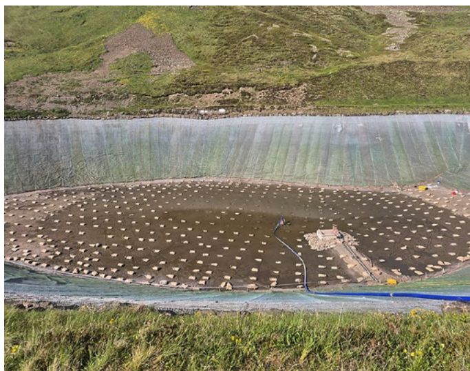
Der gereinigte und reparierte Speichersee Lauberhorn ist parat für die Wasserfüllung
