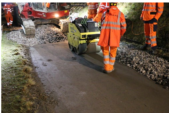
Auf die Planungsschutzschicht kommt später der Schotter
