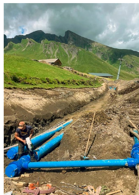
Neue Beschneigungsleitung im Gebiet Grindelwald-First
