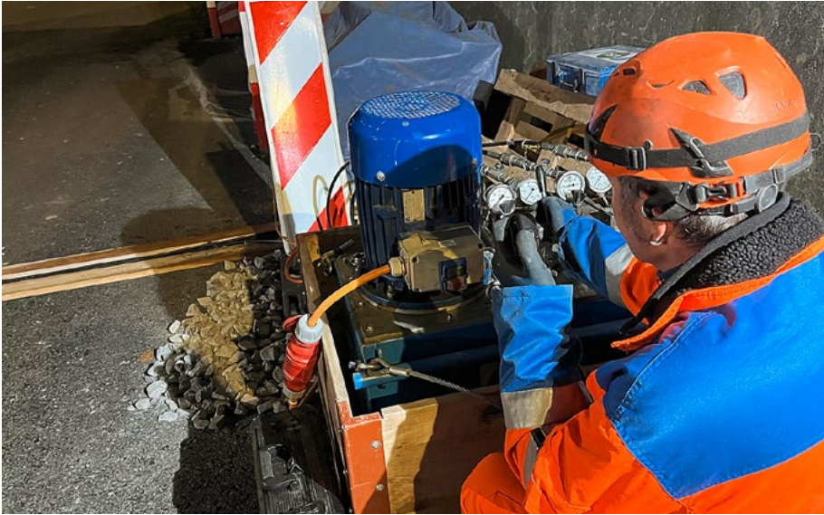
Ein Arbeiter bedient die Hydraulikpumpe
