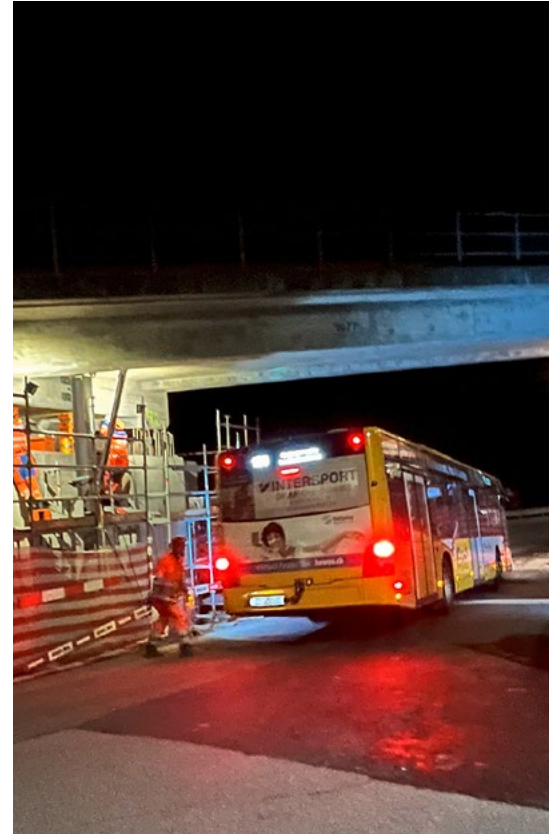
Während der Bauphase verkehren Bahnersatzbusse
