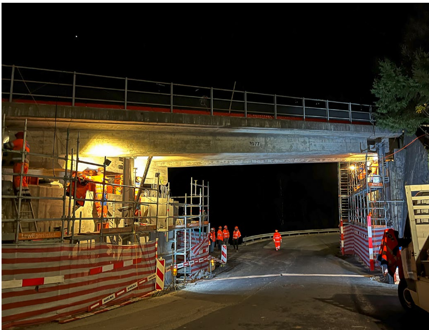
Nächtliche Arbeiten zum Heben der Parkhausbrücke
