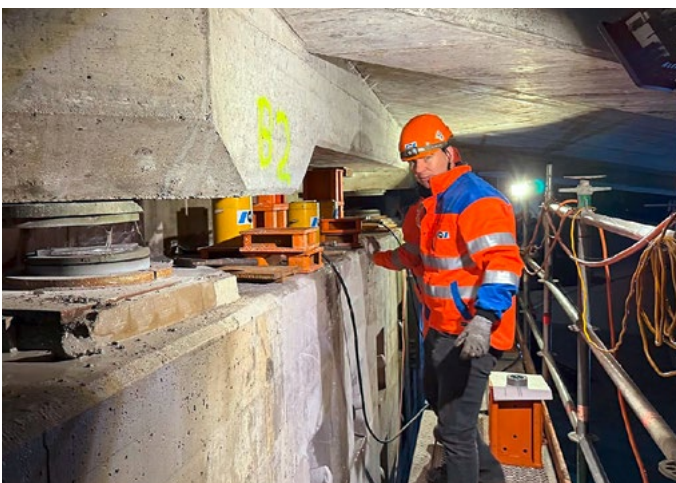
Mit Hydraulik-Pressen wird die Brücke gehoben
