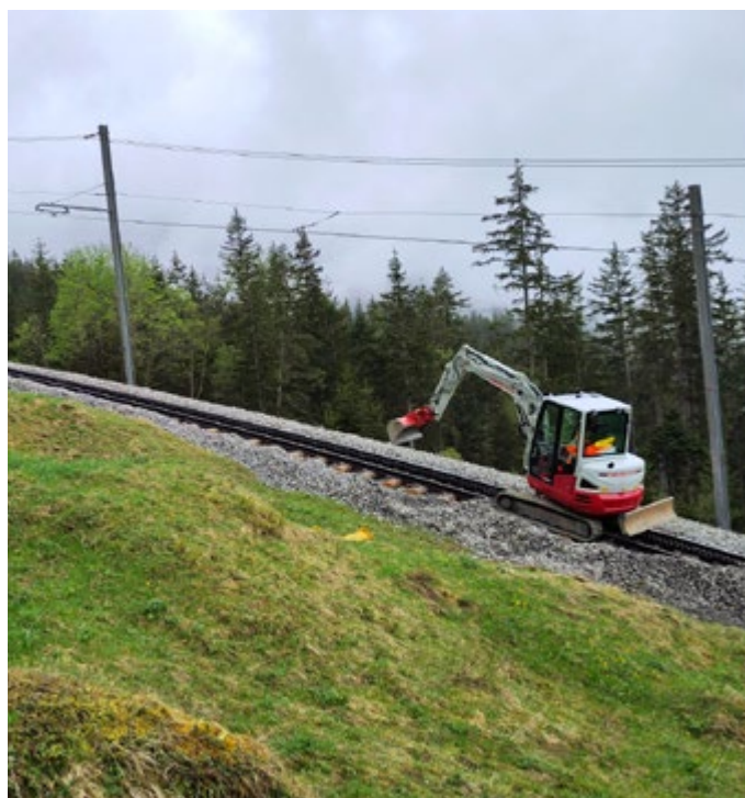
Einschottern des Gleisrosts mit Bagger der WAB und JB
