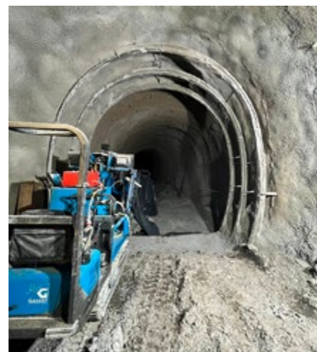
Stabilisierungsmassnahmen im Grätlittunnel
