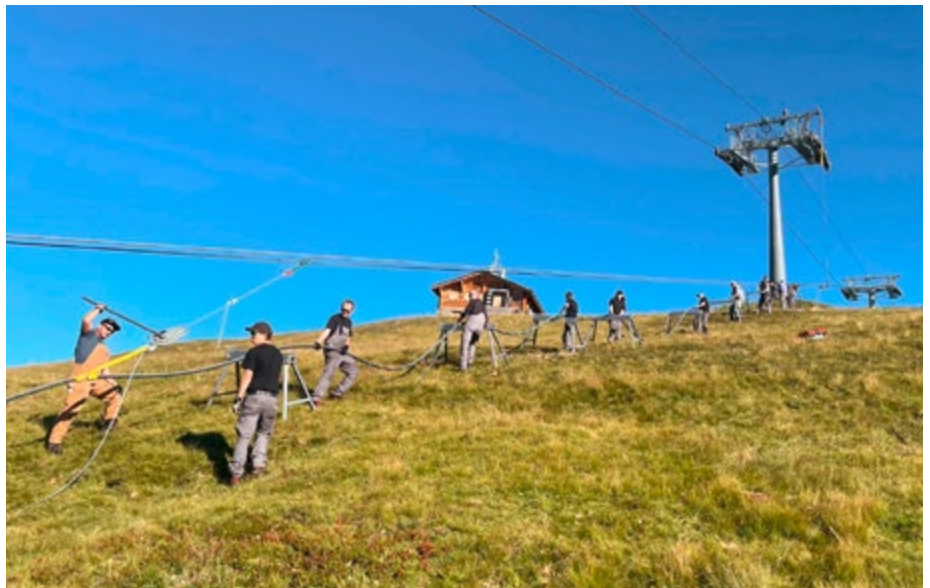
Seil-Spleiss bei der Sesselbahn Wixi
