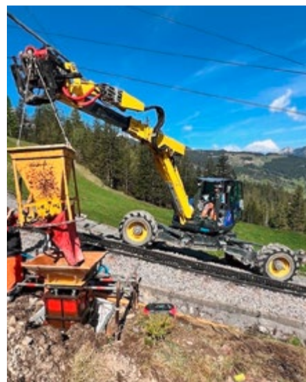
Betonierung eines neuen Fundaments für die Fahrleitungsmasten
