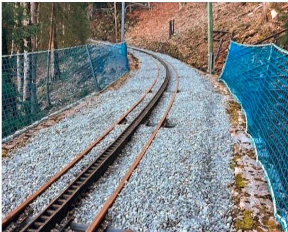
Oberbauerneuerung: Beengter Bauperimeter zwischen Absturzsicherung
