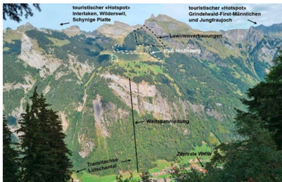
Kurze Projekterschliessung über Weitspannfreileitung ab Lüttschental
