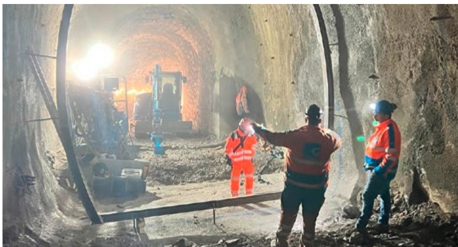
Grätlittunnel: Einbau Stahlbogen zur Verstärkung
