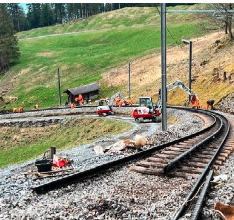
Gleis wird wieder verlegt
