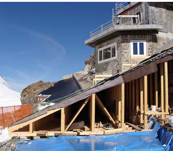
Das Schutzdach wurde steiler gebaut
