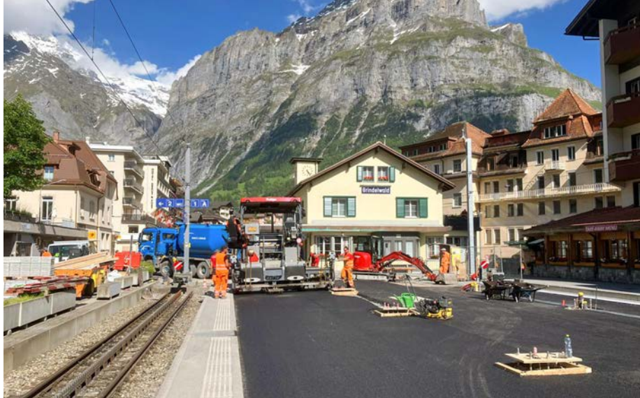
Auf dem grosszügigen Mittelperron wird die Tragschicht eingebaut
