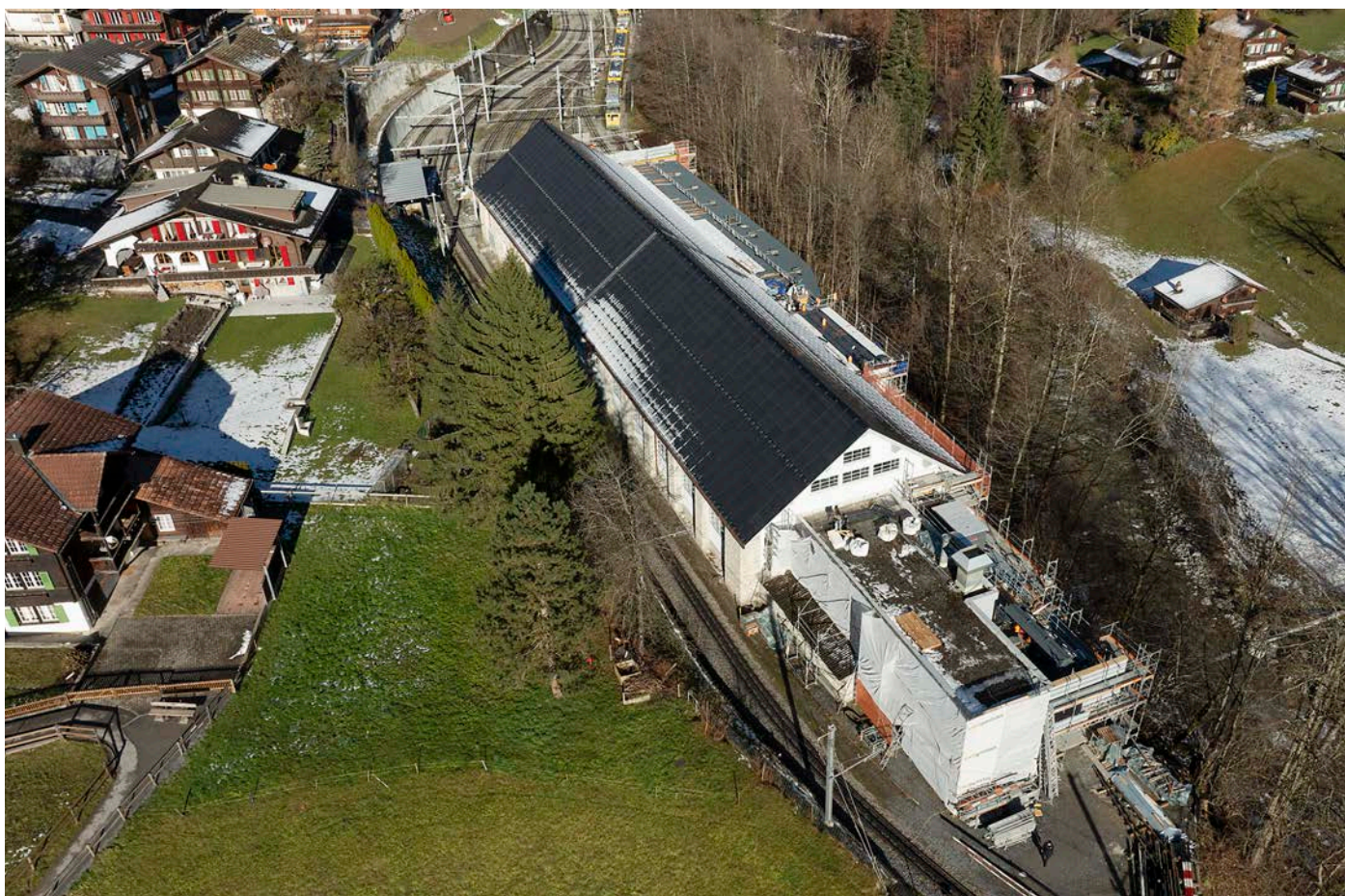
Die Photovoltaik-Anlage auf der Remise erzeugt mehr Energie, als die Remise verbraucht
