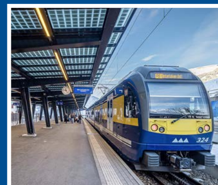
Neues breites Mittelperron und neues Perrondach mit Photovoltaik-Elementen
