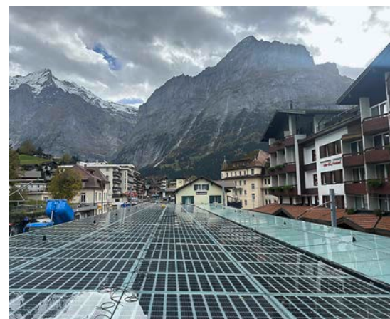
Beim Bahnhof Grindelwald ist die PV-Anlage ins Glasdach integriert
