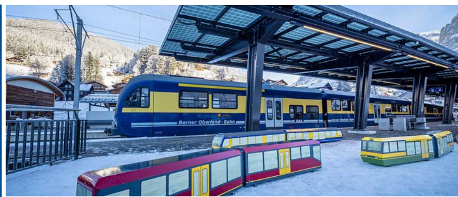
Neues Perrondach mit Photovoltaik-Elementen und neuen, aus Holz geschnitzten Sitzelementen in Zugform
