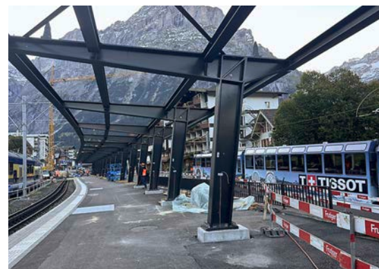
Fertig montierte Stahlkonstruktion
