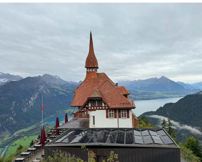
Die PV-Anlage auf dem Harder
