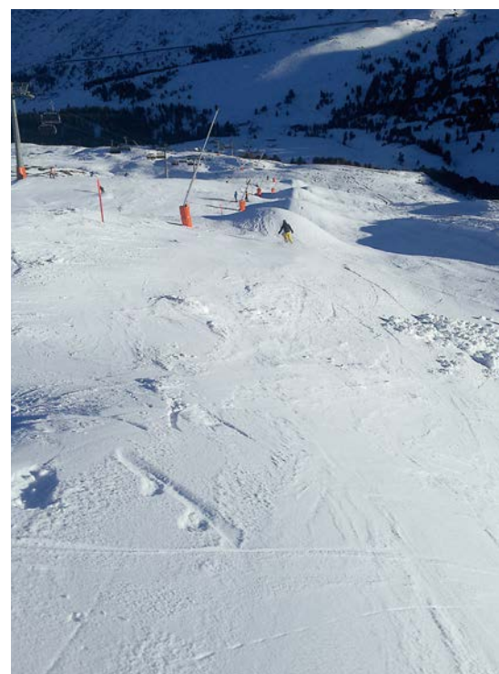
Technische Beschneigung mit fix installierten Schneilanzen
